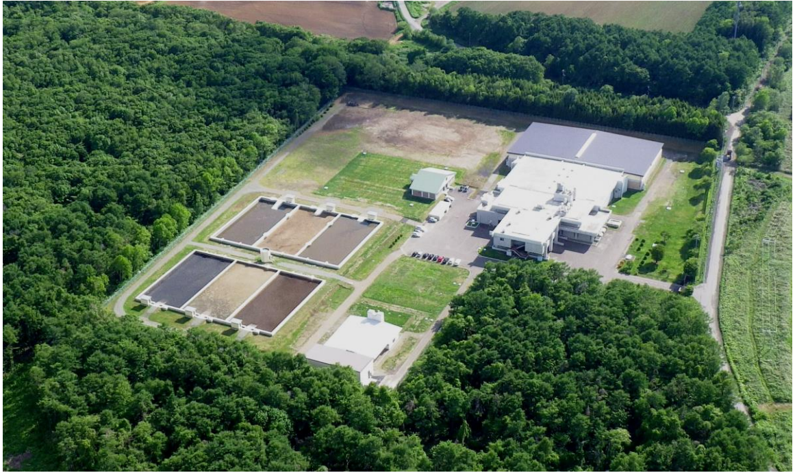
漁川浄水場全景
