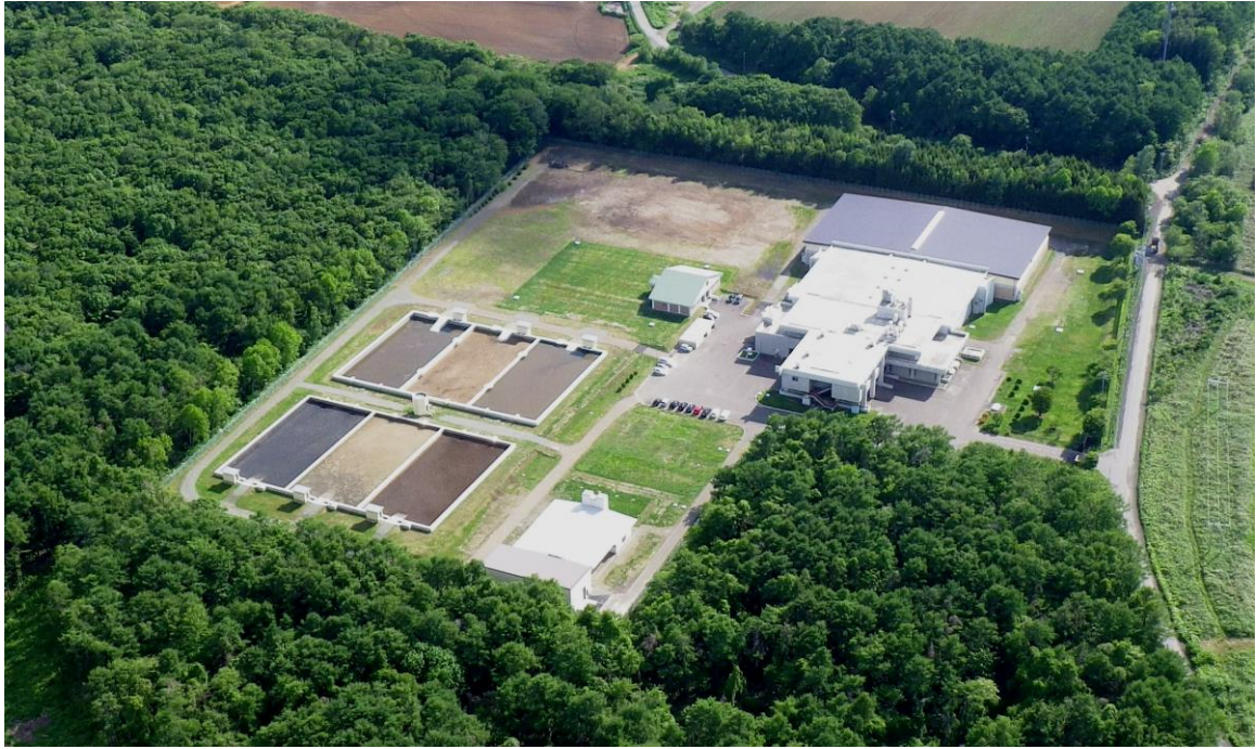
漁川浄水場全景
