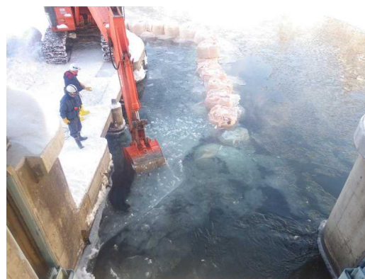
取水口土嚢設置作業状況
