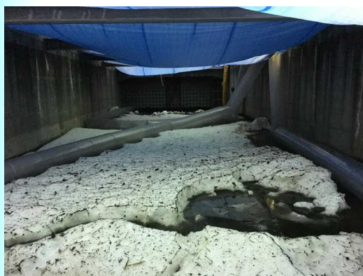
沈砂池採暖状況
