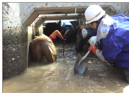
取水口土砂撤去状況
