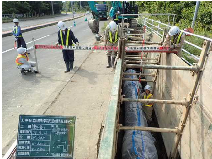
北広島市（中の沢）送水管布設工事その1（平成29年度）
