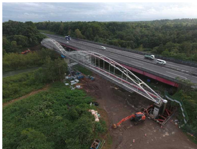
漁川水管橋耐震補強等工事（平成30年度）
