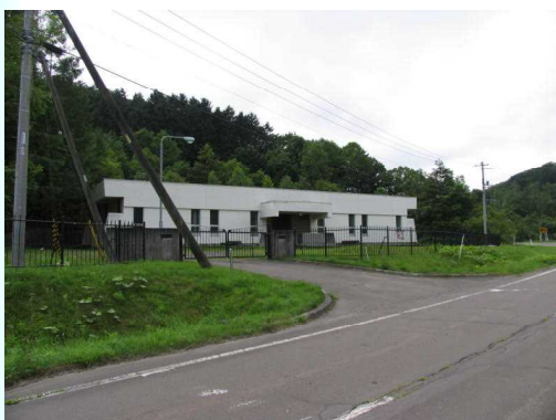
導水ポンプ場
