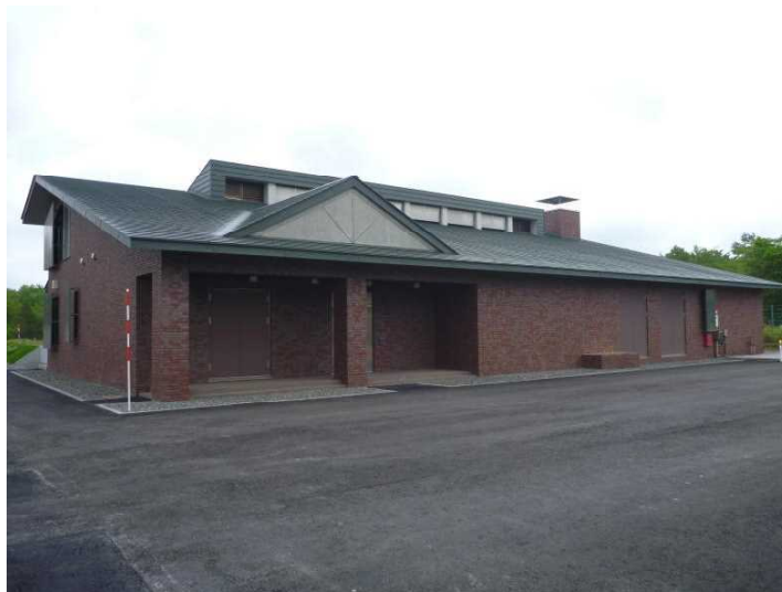
第一中継ポンプ場
