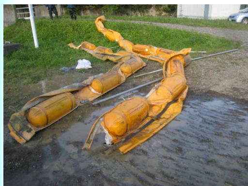
オイルフェンス(取水口)破損状況
