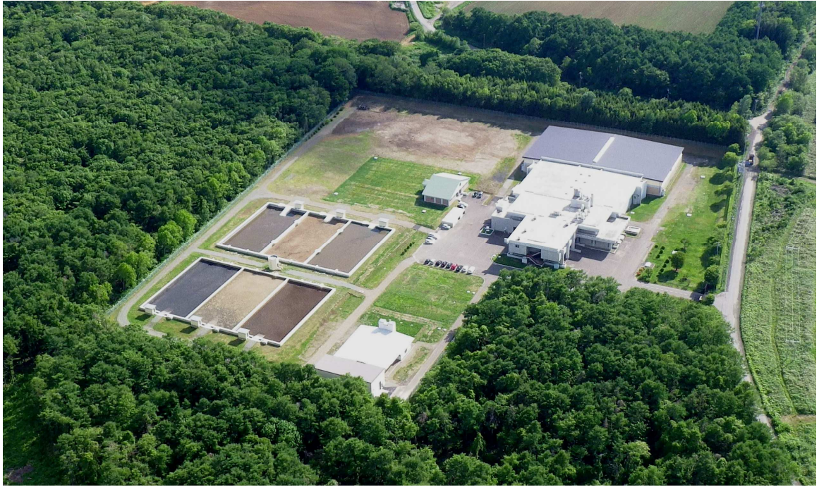
漁川浄水場全景
