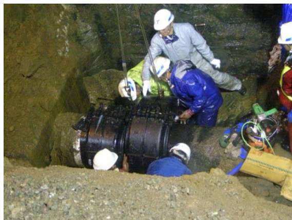
写真 3-3-3 送水管漏水復旧作業
