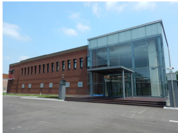
写真 2-1-2 千歳川浄水場
