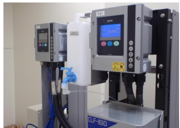
写真 3-4-3-4 水質連続計器による監視
