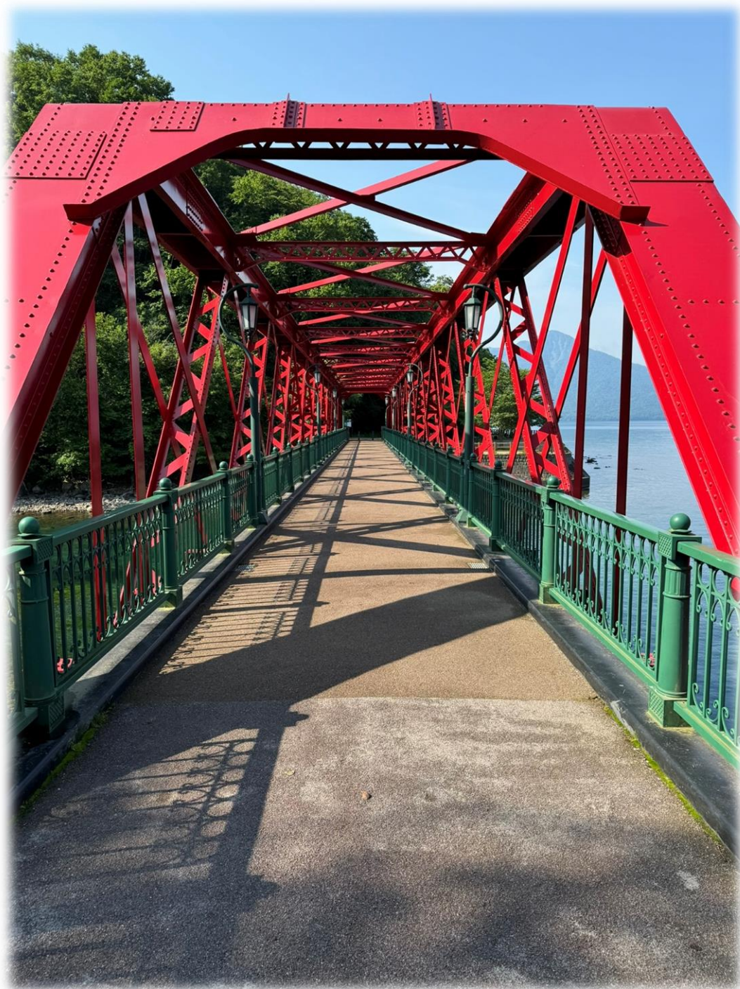
写真：山線鉄橋（支笏湖）
